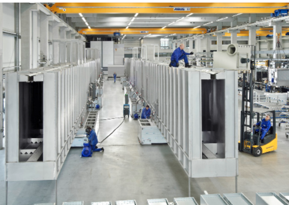
Moderne Fertigung: Großzügige und helle Produktionshallen zeichnen das Unternehmen aus.
